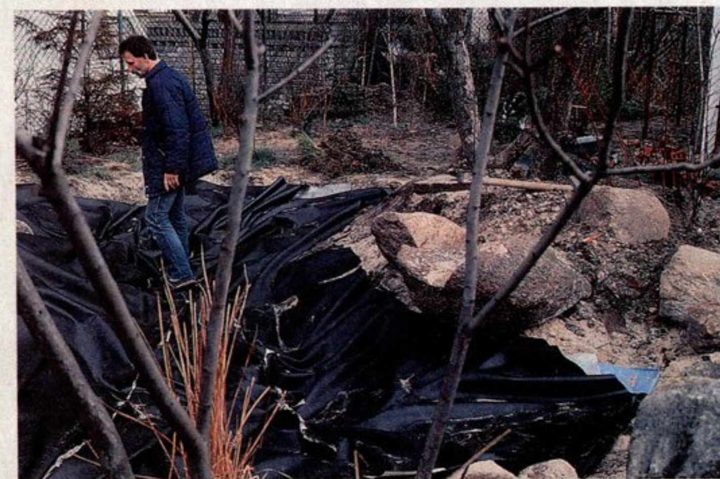
Układanie folii w wykopie. Konieczne jest dokładne ułożenie fałd folii
