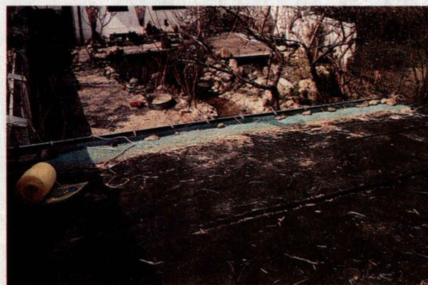
Na folii PE rozłożono folię PCW i siatkę zabezpieczającą brzeg dachu przed erozją
