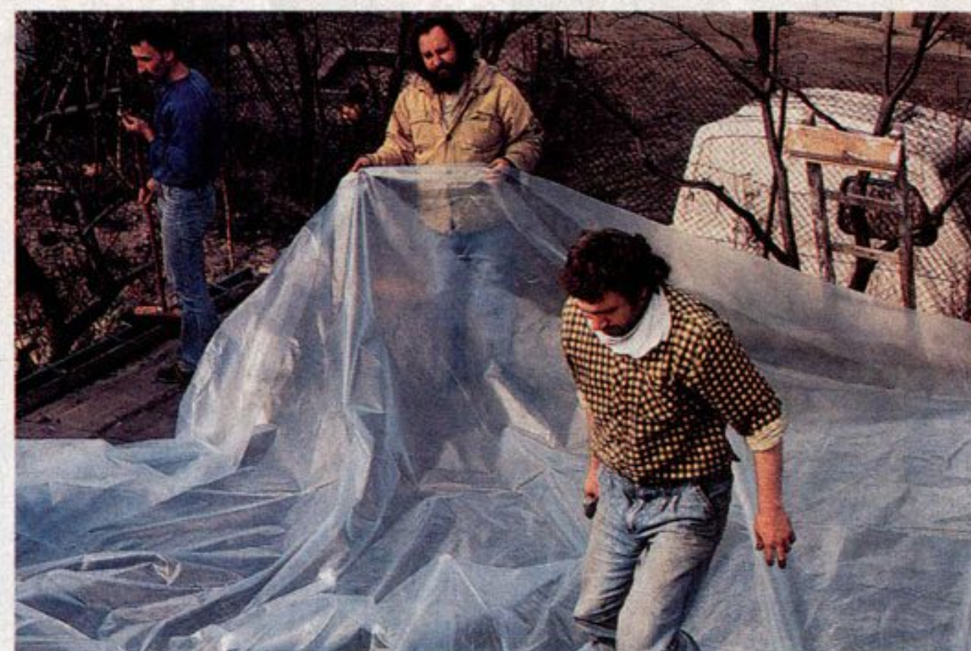
Na odsłoniętym deskowaniu dachu ułożono najpierw zwykłą folię polietylenową, jakiej używa się na tunele foliowe
