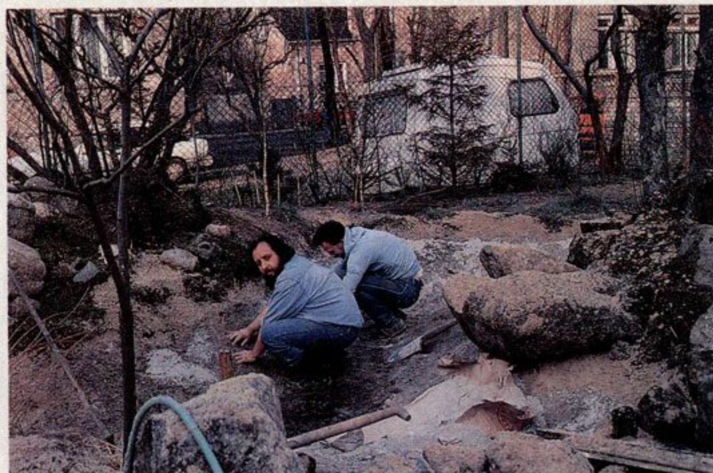
Budowa stawu – dno niecki przed wyłożeniem folią ustabilizowano podsypką piaskowo-cementową
